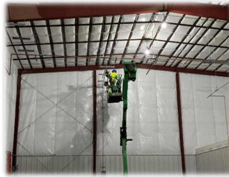
Electrical Wire Conduit Installation
